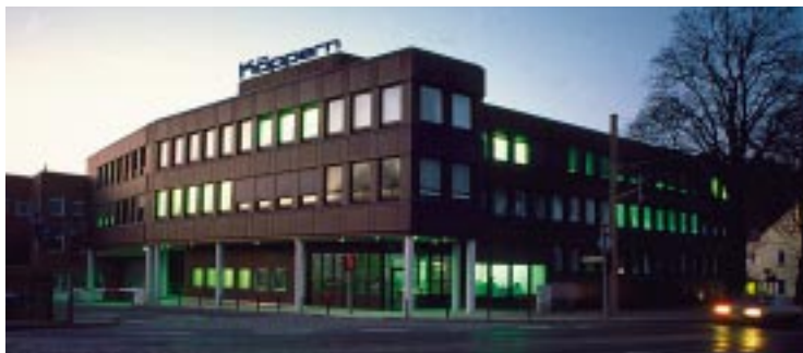
Bürogebäude Head office
